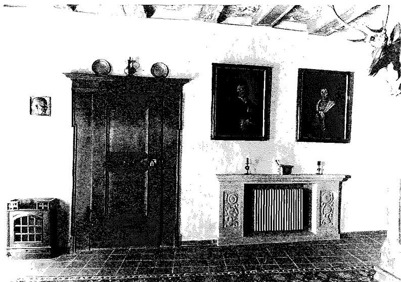
Abb. 18. Die nach dem Umbau entstandene Eingangshalle. Eine historische Neuschöpfung aus originalen, kopierten und nach-
